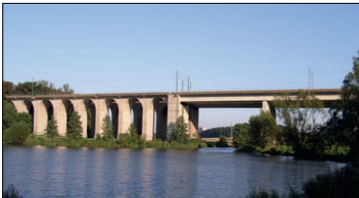
Brücken: Viadukt in Schildesche
